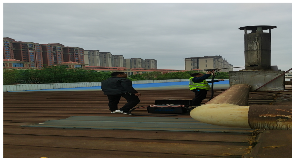
有组织废气排气筒
